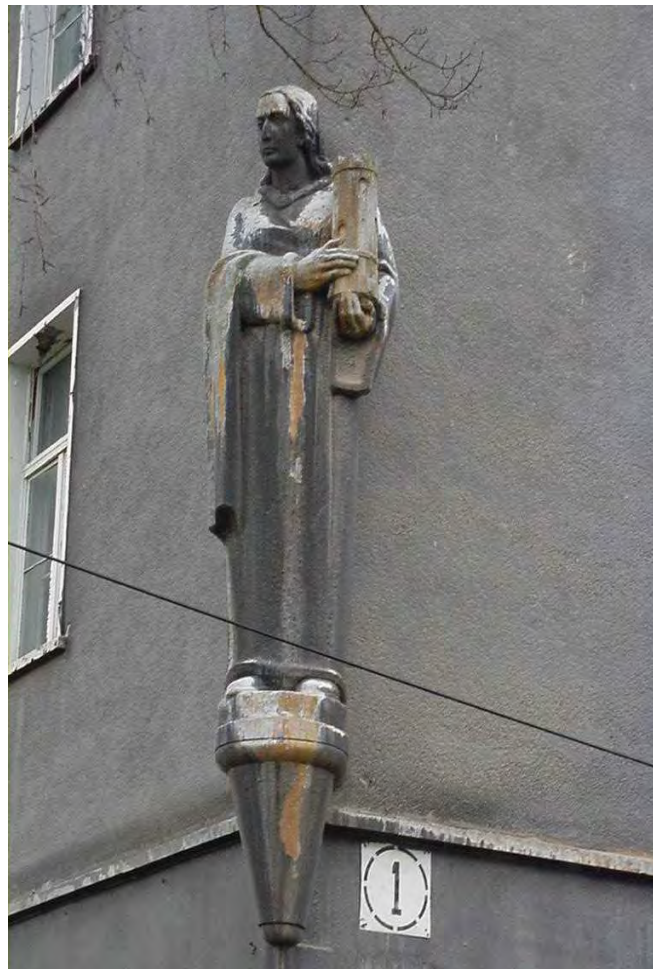
Zustand unmittelbar vor dem Abriss
