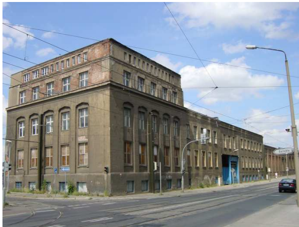
Denkmalgeschützte Fassade entlang der Schönebecker Straße
