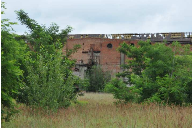
Blick von Westen auf die Rückseite der denkmalgeschützten Bebauung
