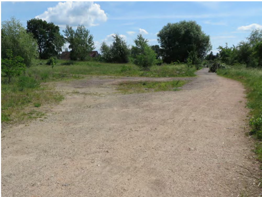
Abb. 4: Zentralteil des UG, Verlängerung des Hohefeld-Privatweges, unbegrünte befestigte Fläche
