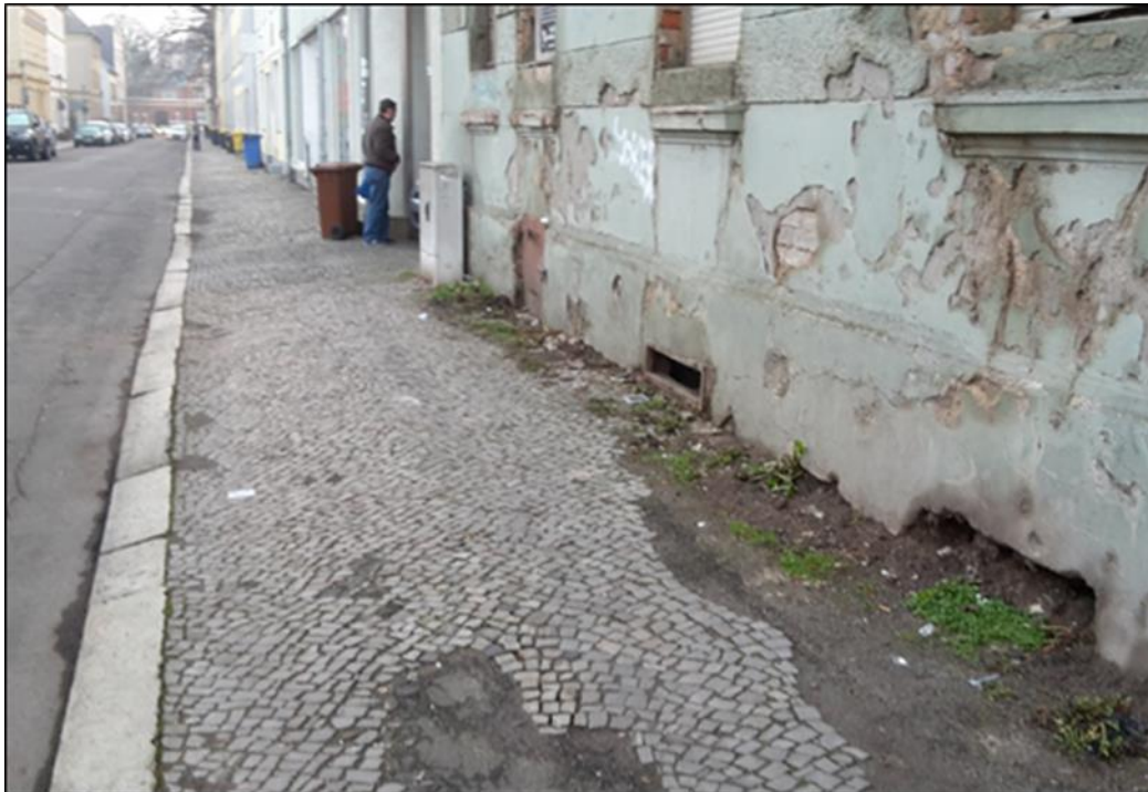
Die Gehwege sind stark uneben. Teilweise ist im Traufstreifen das Material verloren gegangen und diese Bereiche unbefestigt.
