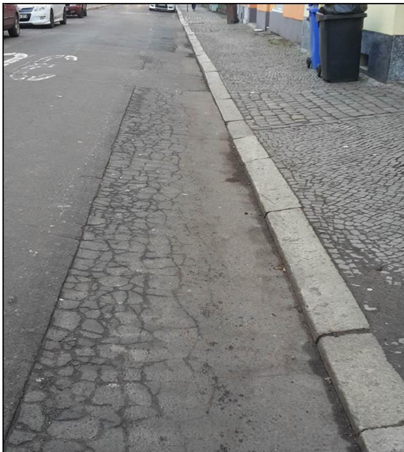
Die Gehwege sind stark uneben. Teilweise ist im Traufstreifen das Material verloren gegangen und diese Bereiche unbefestigt.
