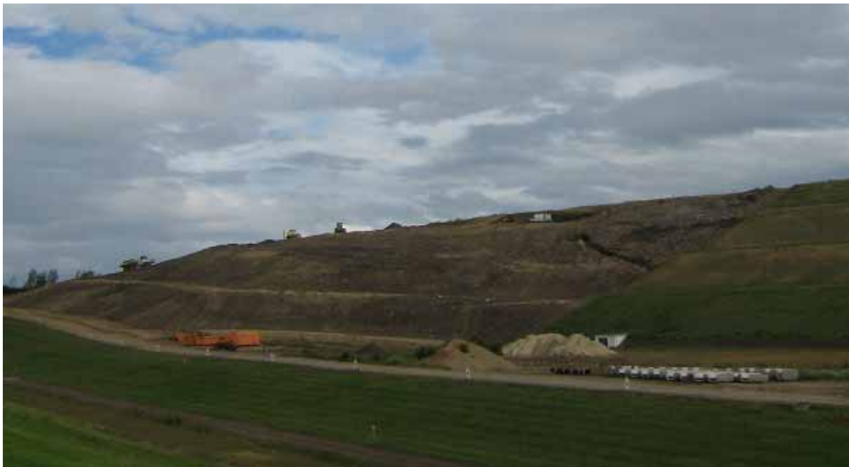
Abbildung 21 Temporäre Oberflächenabdeckung, 3. BA
