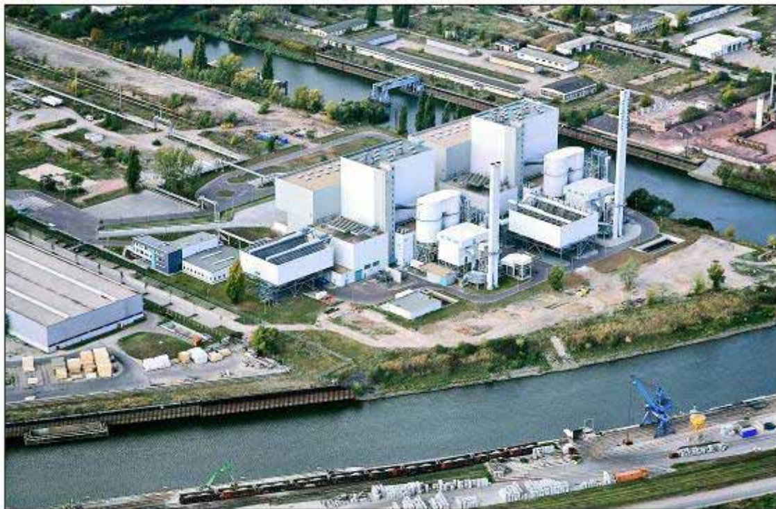
Abbildung 8 Blick auf das Müllheizkraftwerk Rothensee
