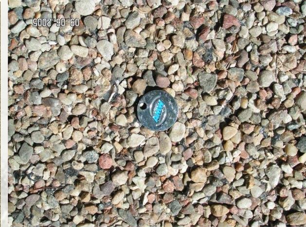
Variante 3 / abgestreuter Farbasphalt (Optik einer wassergebundenen Decke)
