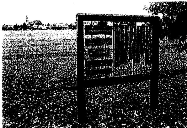
Die Fundamente der Tafelträger sind mit Boden anzufüllen, damit die Fundamente nicht freistehen. Zudem wurden an allen Tafelträgern der Standraum von Wildwuchs befreit, so dass die Füße freistehen und weniger der Witterung ausgesetzt sind.
