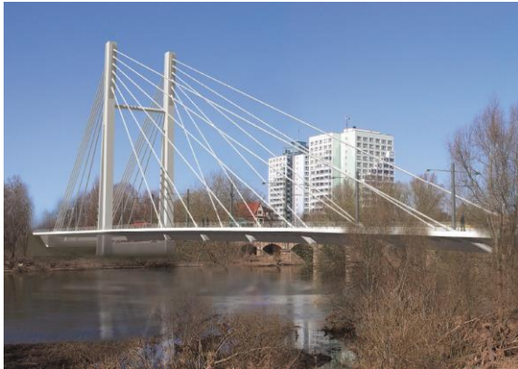
Pylonbrücke mit Querriegel und 6 Seilen
