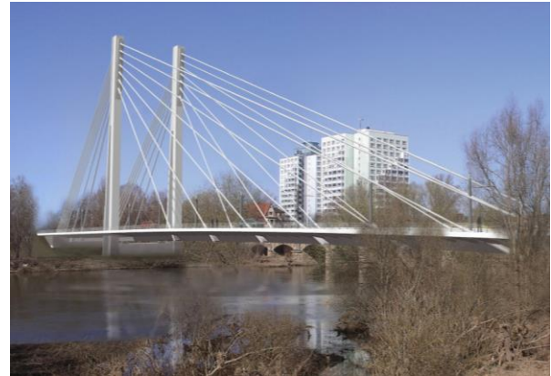
Pylonbrücke ohne Querriegel und 7 Seilen
