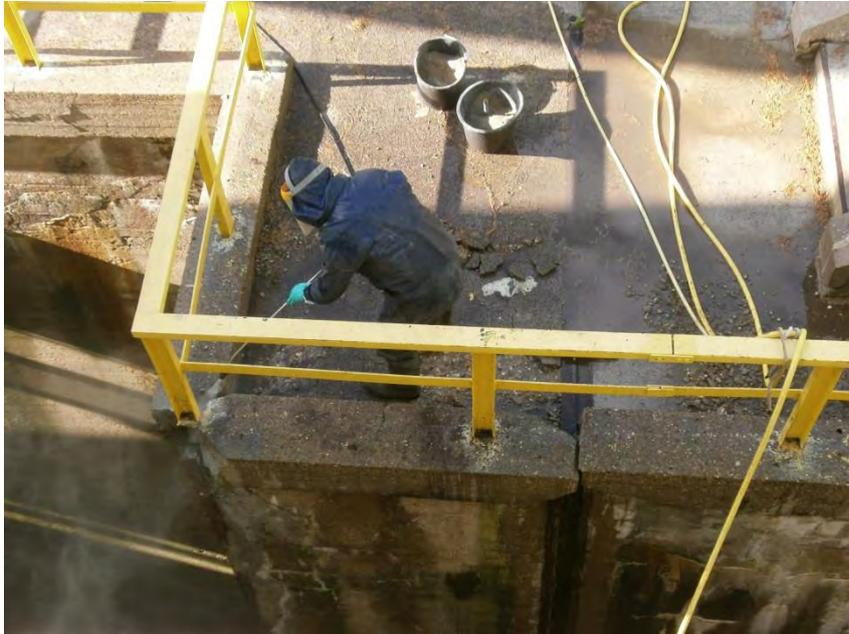
Abb. 18: Umlauf Trogkammer West Betoninstandsetzung
