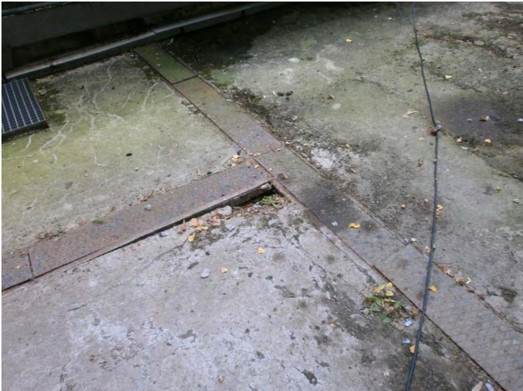
*Abb. 17: Dehnungsfugen im Bereich Restwasserbecken*
