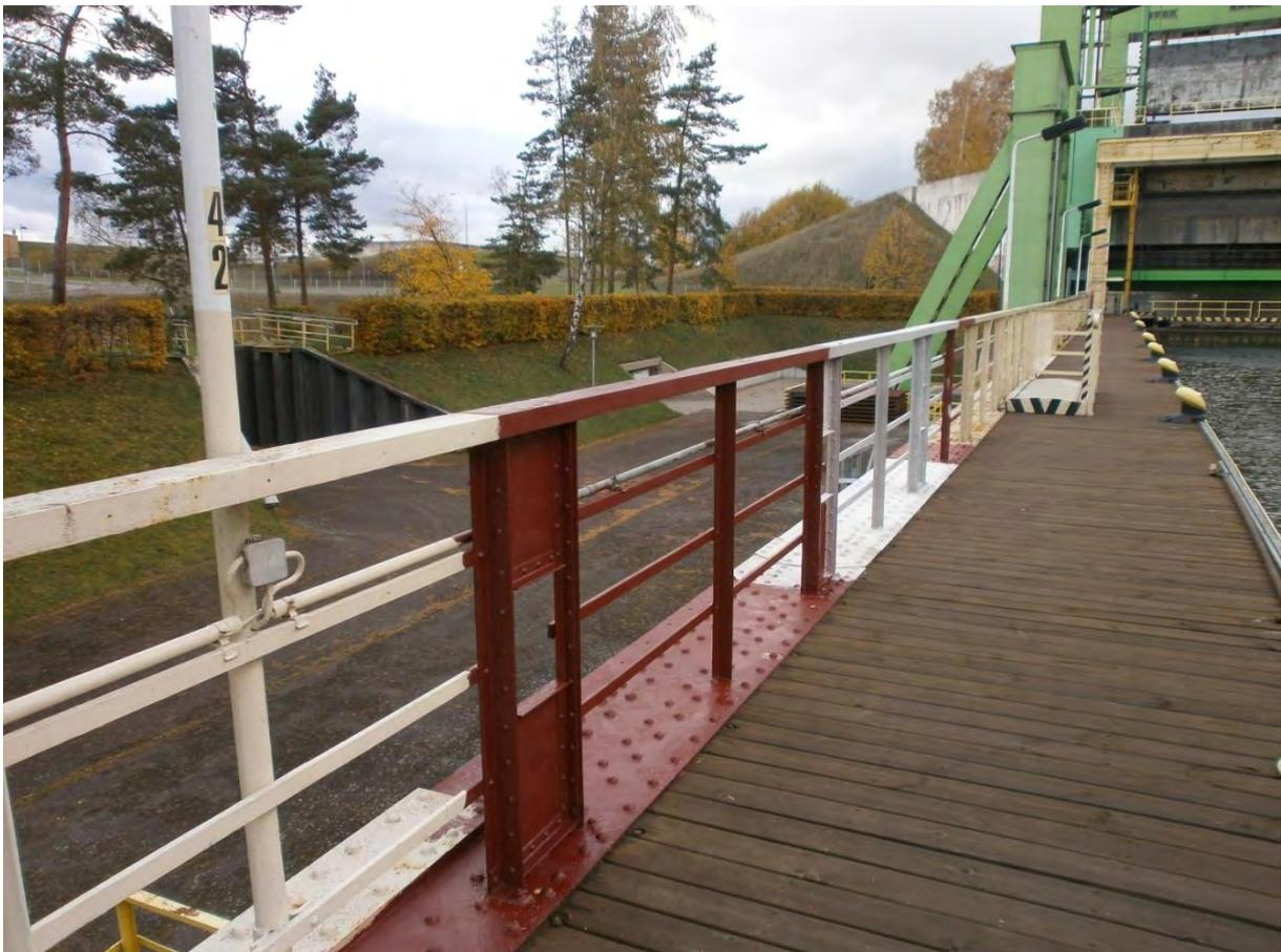
*Abb. 12: Trogeländer Westseite nach Korrosionsschutzmaßnahmen*
