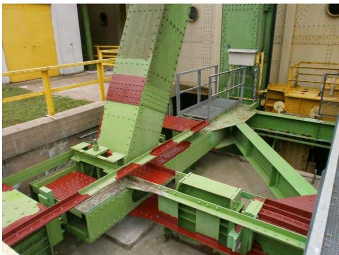
Abb. 10: Spindelportal Südost nach Korrosionsschutzmaßnahmen
