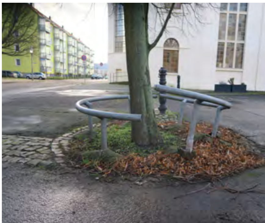
Brüchiges Inventar, die Funktion wird nicht mehr erfüllt
