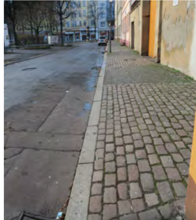
Keine Barrierefreien Zugänge und Wege im Bereich des Parkplatzes
