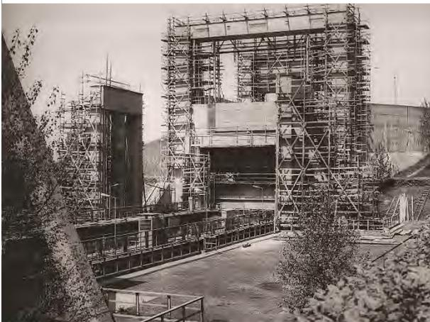
Abb. 2 Generalreparatur Schiffshebewerk 1980-1982 (Quelle:
