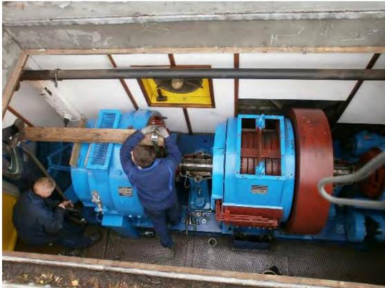
Abb. 24 Demontagearbeiten Umformersatz
