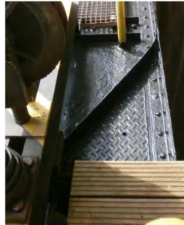
Abb. 17 Zwischenbeschichtung
