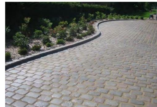
Variante 1: Großpflaster in Kombination mit Kleinpflaster, grauer Granit
