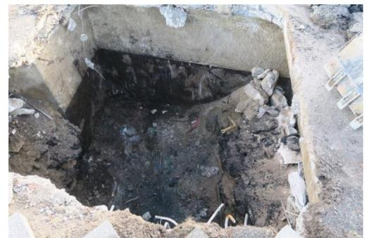
Dieses Gebäude wurde damals im Zuge der Umgestaltung der Freifläche größtenteils mit Boden und Asphalt verfüllt bzw. überpflastert. Auf Grund der zahlreich im Umfeld des Gebäudes vorhandenen Versorgungsleitungen ließ sich nur im Gebäudeinneren eine Sondierbohrung durchführen. Dazu musste die Stahlbetondecke und die Verfüllung beseitigt werden.
