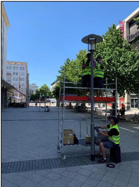
Bild: Vormontage der Stromversorgung
