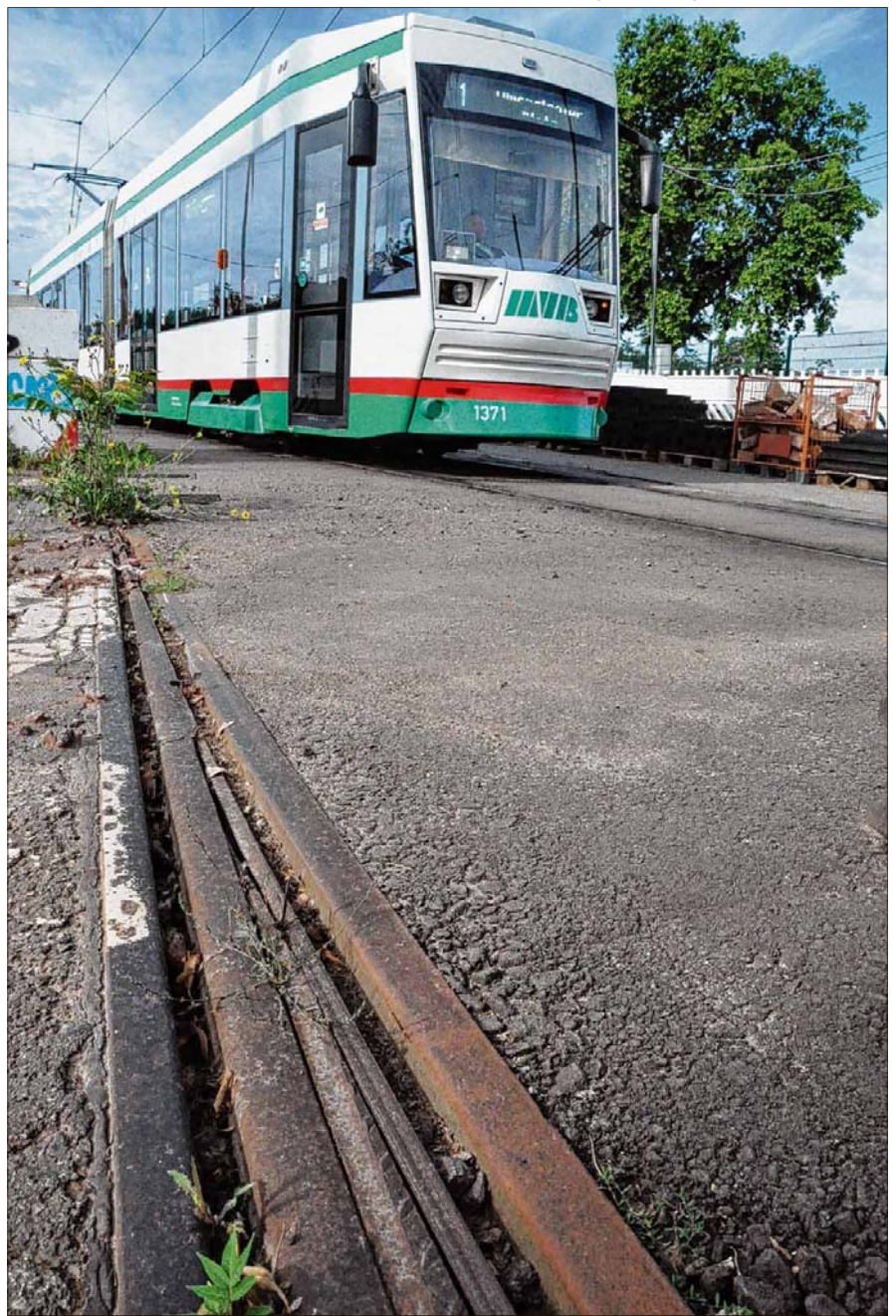
Auf einem Ersatzgleis fahren die Straßenbahnen im Adelheidring derzeit an dem maroden alten Gleis vorbei. Dieses soll ab Ende August ausgetauscht werden. Foto: Martin Rieß
