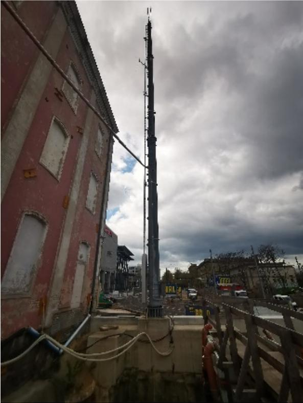
Bild 23: Sendemast Funk und Alarmierung als Teil der Tunnelbaustelle
