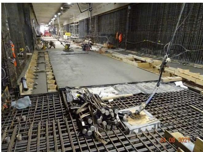
betonierte Tunnelsohle Ost
