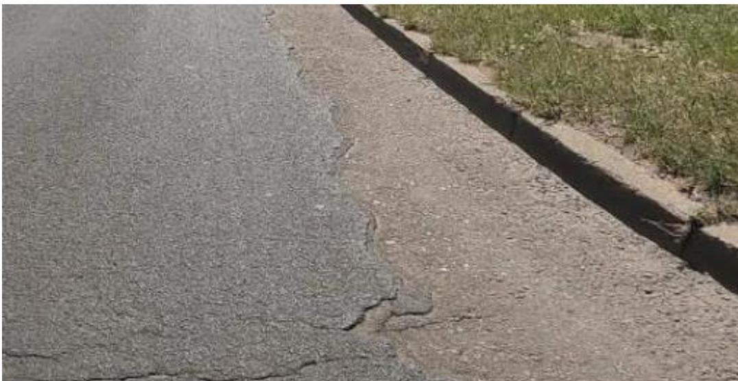
Abb. 5: Schäden an der Fahrbahn bei Stat. 0+150.00
