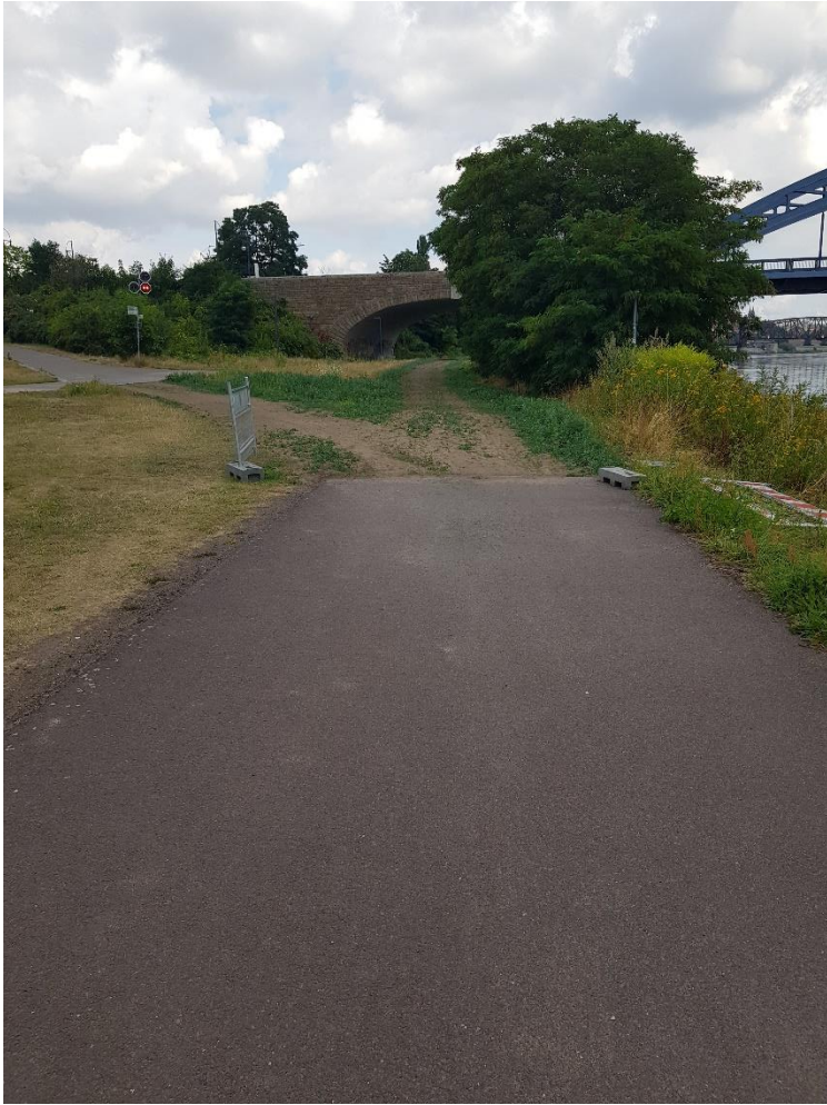
Anbindung an den Bestand Höhe Sternbrücke
