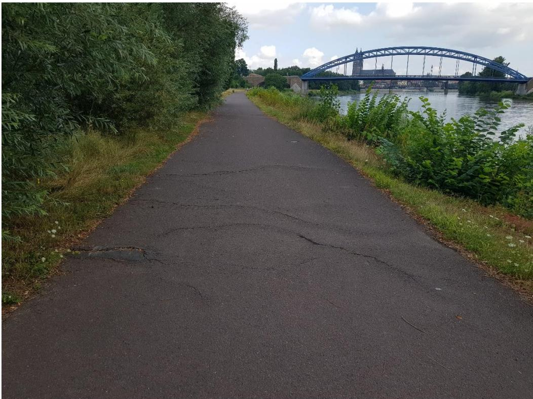
Uferweg entlang der Elbe mit sichtbaren Schäden in der Schwarzdecke aufgrund des Wurzelwachstums der vorhandenen Bäume aufweist.
