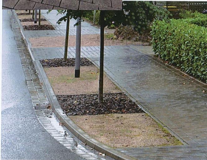
Pflanzgraben mit tragfähigem und durchwurzelbarem Substrat aufgefüllt
