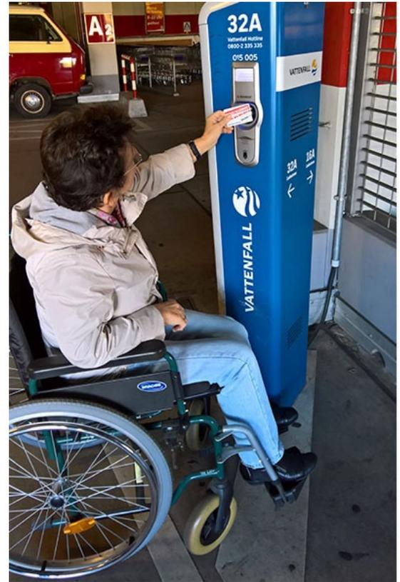
Abb. 45 Ladesäule mit weniger berücksichtigten Anforderungen für die Barrierefreiheit (Bildquelle: [www.nullbarriere.de](http://www.nullbarriere.de))
