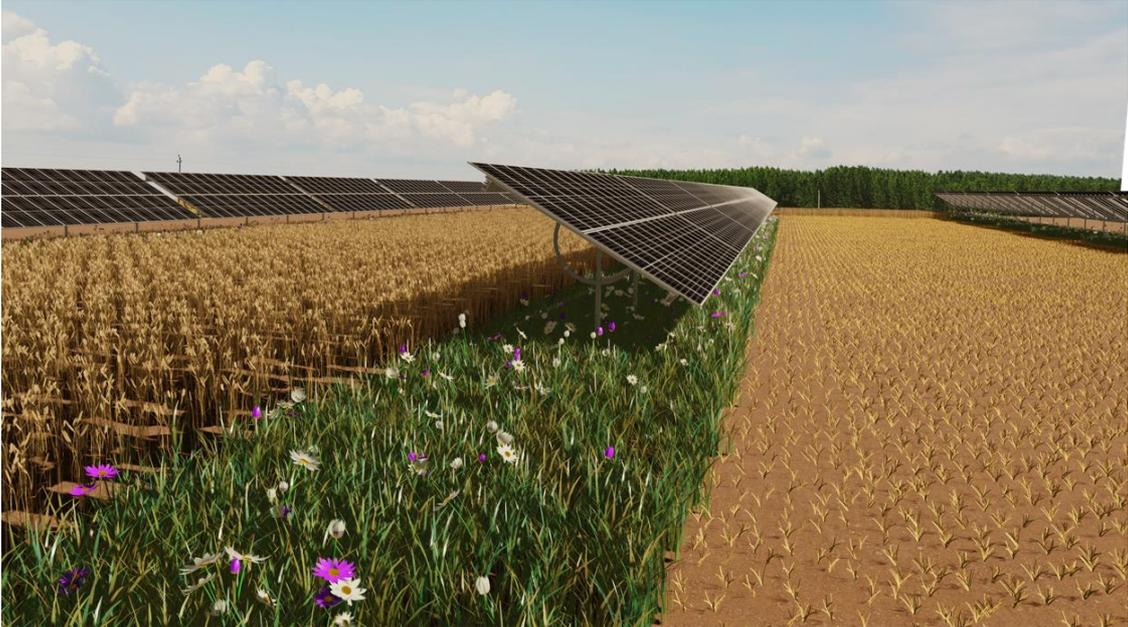
Beispielhafte Darstellung der geplanten Agri-Photovoltaik Solarfelder. Die in diesem Projekt geplante Variante der Agri-Photovoltaik wird auch als Agri-PV Plus bezeichnet. Zwischen den Photovoltaikmodulen wird die Fläche landwirtschaftlich genutzt. Unterhalb der Photovoltaikmodule ist die Anlage eines Blühstreifens geplant. So findet eine Dreifachnutzung der Fläche statt: Landwirtschaft, Energieerzeugung und Biodiversität.
