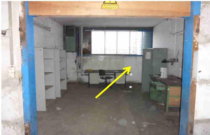
Bild 1: Entnahmestelle Wandfarbe Halle I
