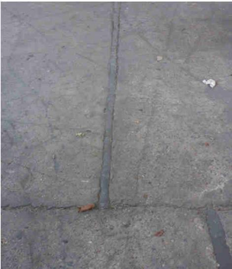
Bild 2: Fugenmassen in Lagerhalle
