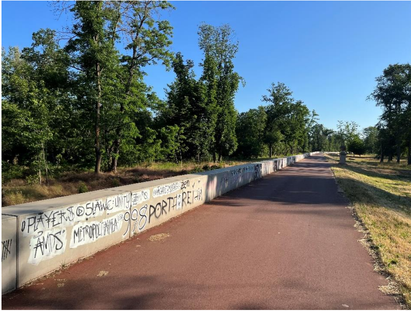
Anlage: Hochwasserschutzanlage im Herrenkrug (Foto: Manuel Rupsch)
