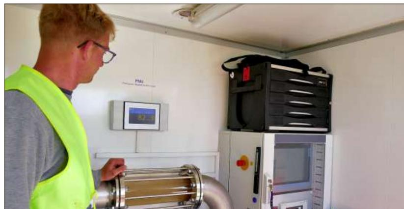
SWM-Mitarbeiter Florian Horenburg inspiziert die Überwachung der Daten, die den Reinigungsgrad der Rohrleitung anzeigen. Das getrübbte Wasser wird ins Abwassernetz eingeleitet oder über Standrohre entsorgt. Die Rohrspülung ist beendet, wenn das Wasser wieder klar ist und vorgegebene Messdaten erreicht werden. Foto: SWM
